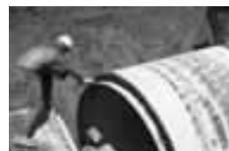
p.39, Anni Novanta, posa di una condotta idrica
