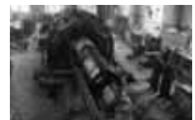
p.40, 1946, CM, collocamento rotore nell'alternatore
