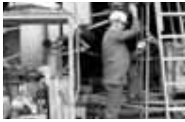
p.68, 1999, cabina primaria Laurentina, operaio
